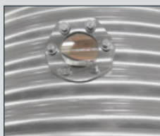
2 OKIENKA REWIZYJNE: W SILOSIE I W LEJU
